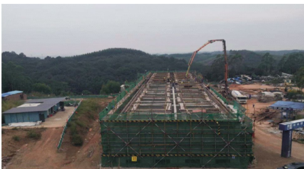
图2 混凝土浇筑
