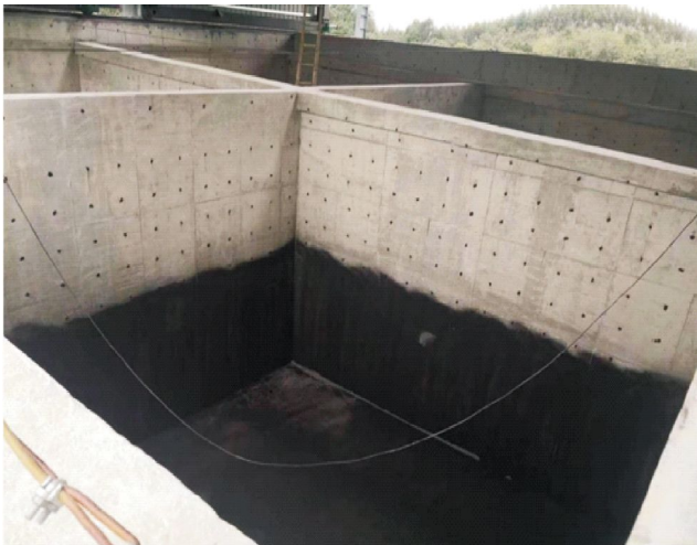
图3 环氧沥青涂膜施工
