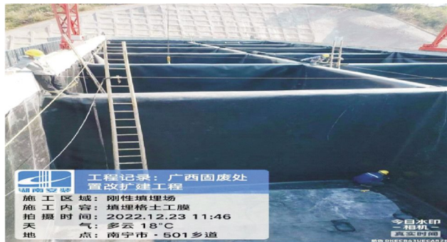
图4 HDPE膜施工
