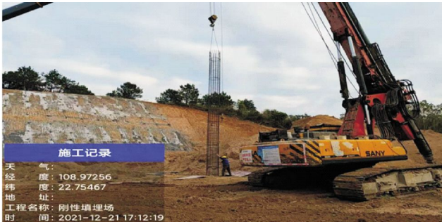
图1 桩基础施工
